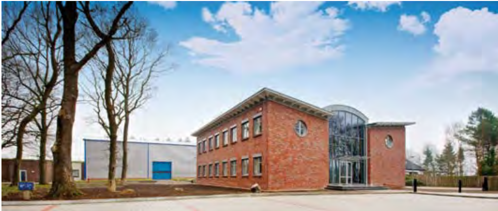
☛ Firmengebäude des Wasserversorgungsverbandes Wesermünde-Mitte
