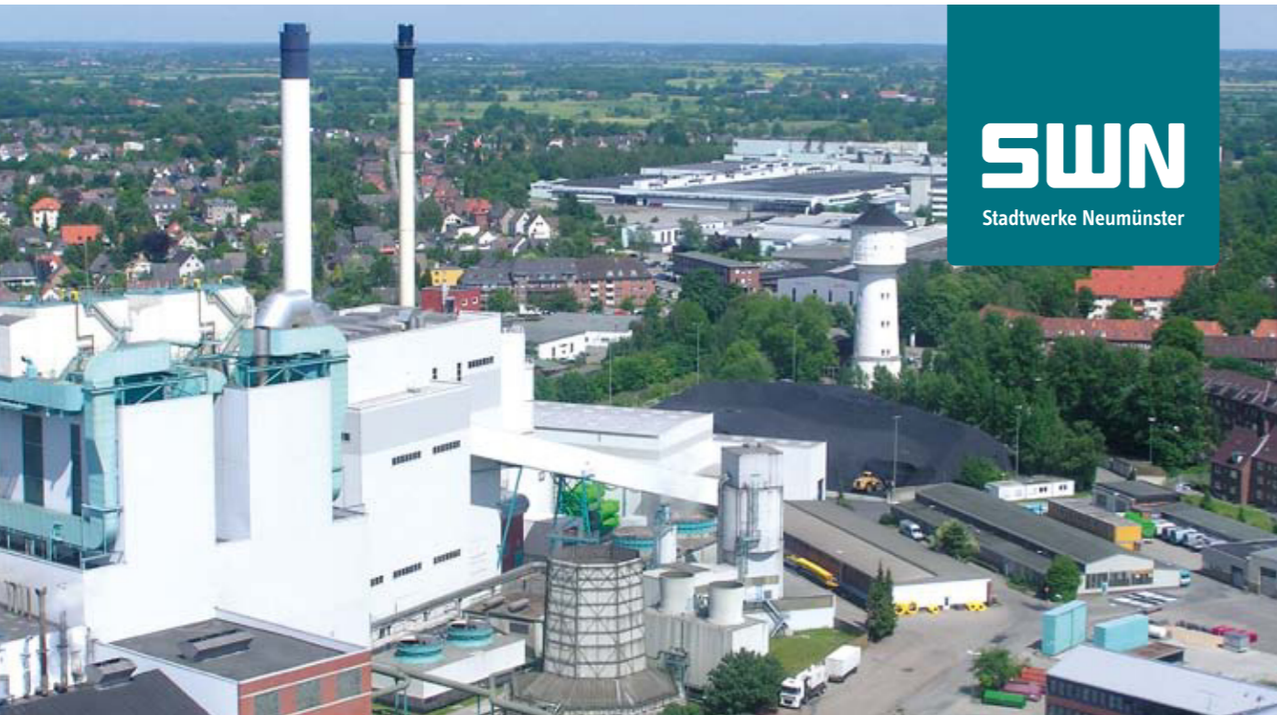
Abb.: Das Heizkraftwerk der Stadtwerke versorgt Neumünster mit Fernwärme.
