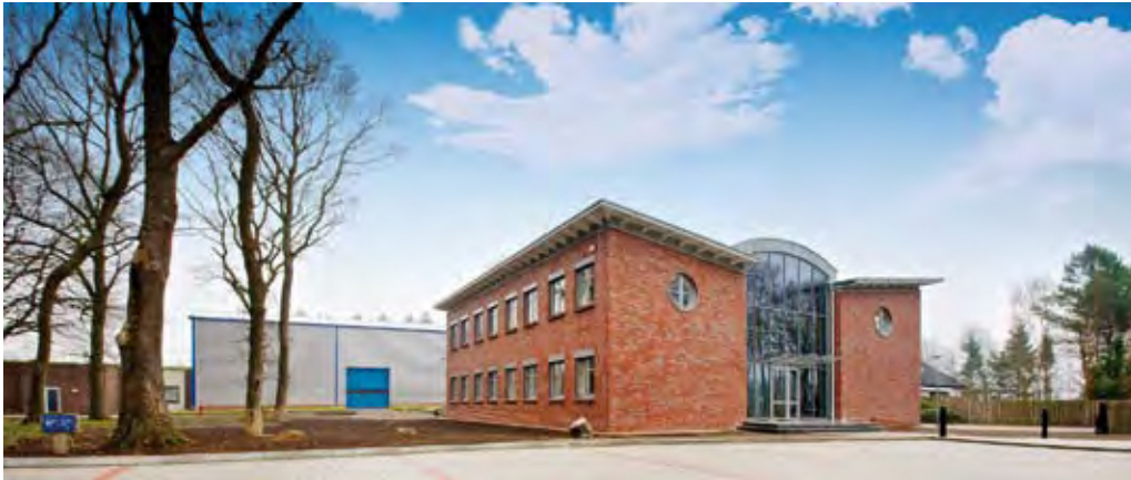
☛ Firmengebäude des Wasserversorgungsverbandes Wesermünde-Mitte
