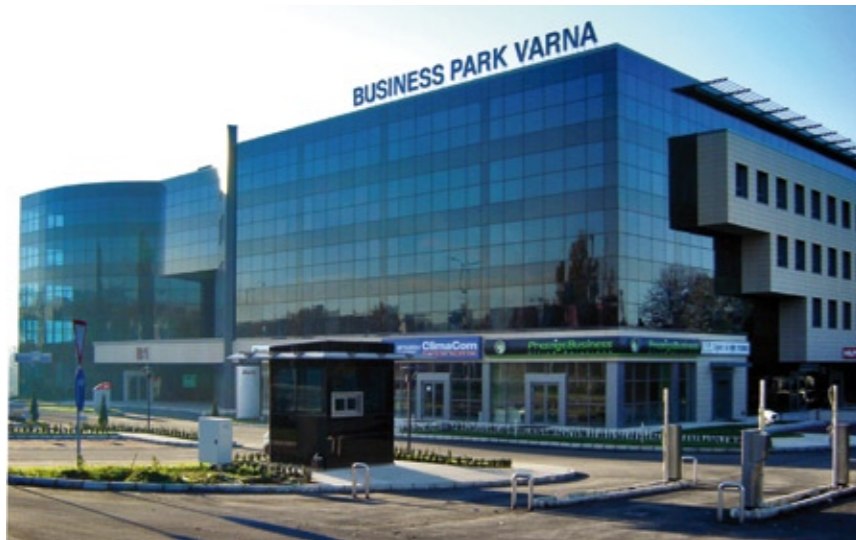
Abb.: Firmenzentrale der SIV.BG EOOD im Business Park Varna
